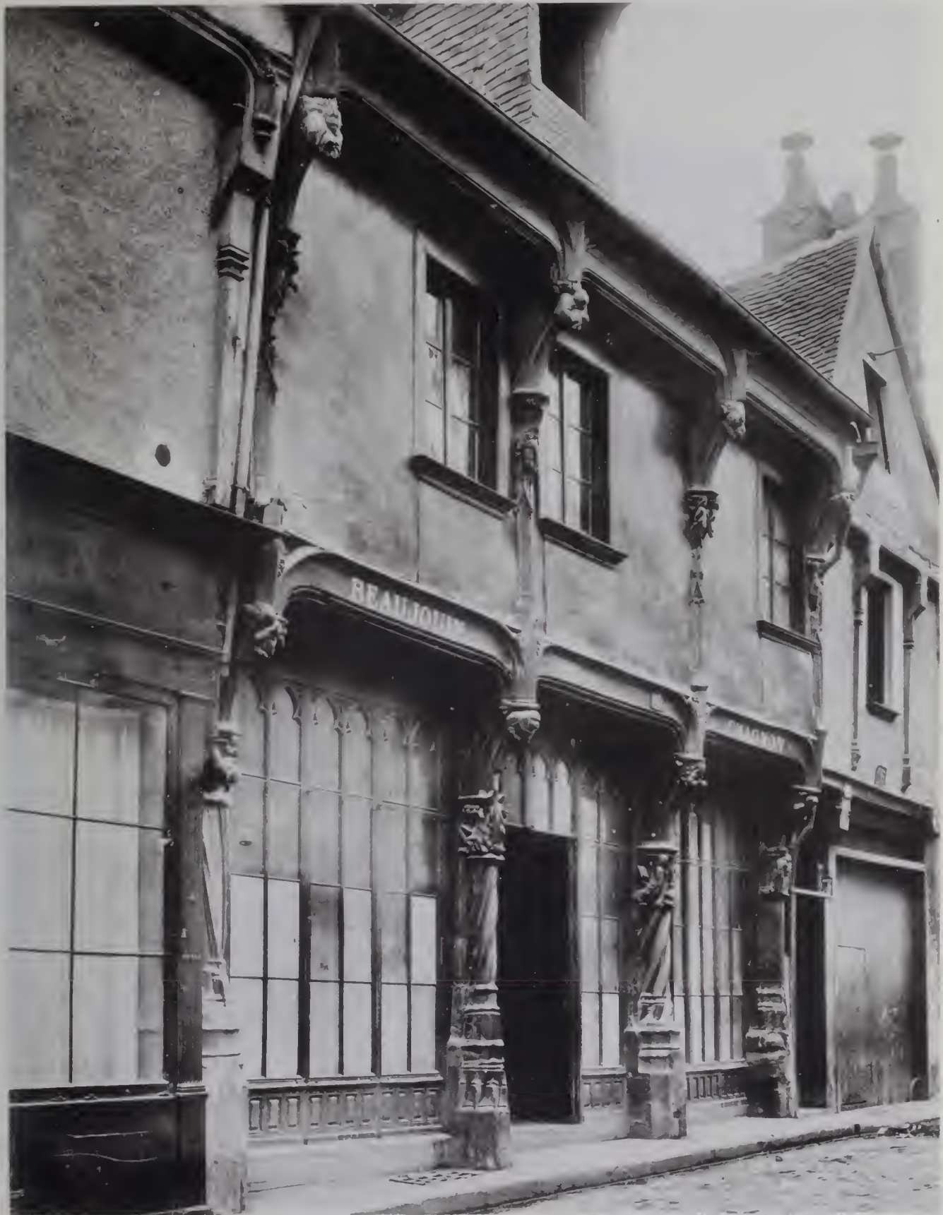
BOURGES—FACADE OF AN ANCIENT HOUSE, DE LA REINE BLANCHE.
